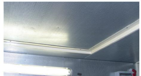
**Schalldämmung** (innen) durch Verwendung von Lochblech statt Glatblech
